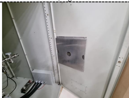
Figura 10. Blindagem adicional em chumbo na região com doses superiores a 0,5 \mu\text{Sv/h}
